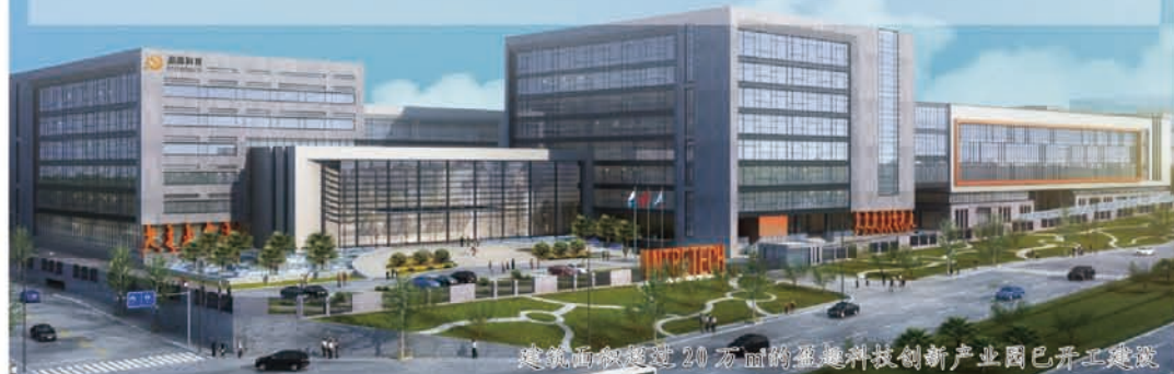
建筑面积近20万平的盈趣科技创新产业园已开工建设
